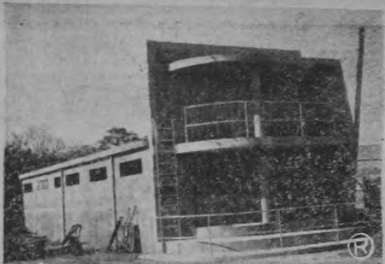
ESTADIO DE ATENAS. —Este es el Estadio de Atenas, que está en construcción bajo la dirección de Obras Públicas. Será el primer centro de esta naturaleza que tenga palco especial para los locutores y los periodistas deportivos.
